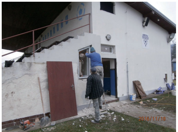
Oprava budovy na ihrisku TJ Žiar Papradno.
